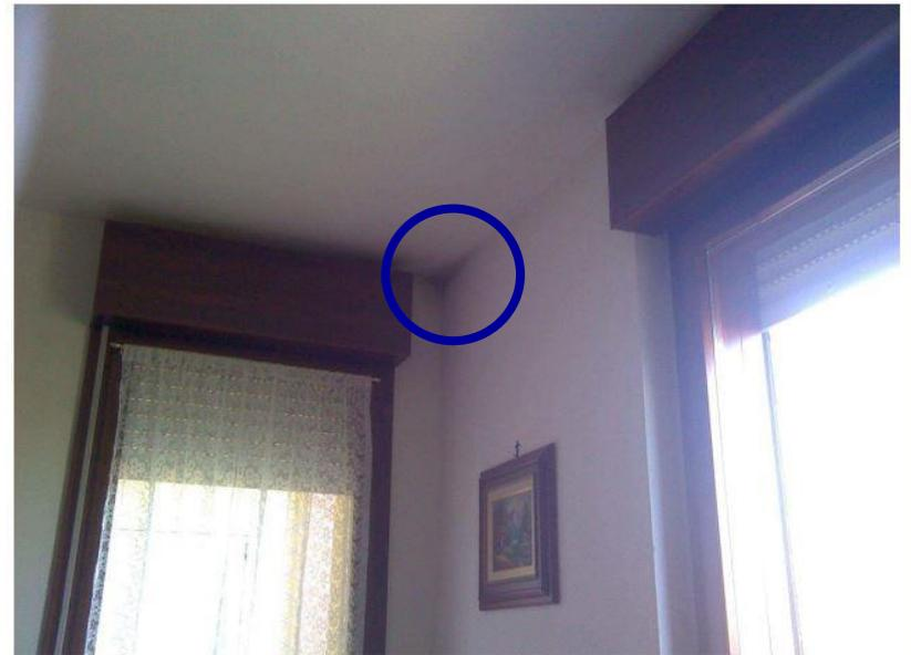
Dall'analisi termografica condotta, è stato possibile evincere come in corrispondenza della macchia di umidità presente nell'angolo di congiunzione tra le pareti e il solaio vi sia una temperatura superficiale inferiore rispetto a quella registrata sulle strutture: vi è la presenza di un ponte termico, sia geometrico che di materiale, possibilmente generato da una carenza di isolamento termico in tale punto.
